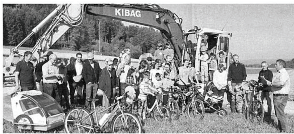
Gemeinderat René Caspar (r.) bei der Begrüssung zum Spatenstich.
