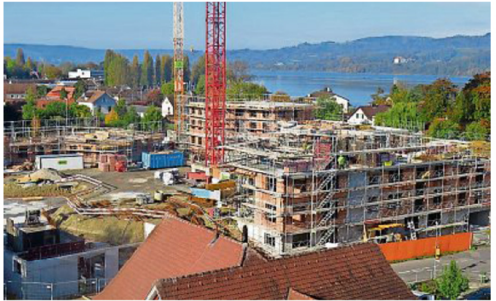
Die Arbeiten sind trotz Planänderungen im Zeitplan.
