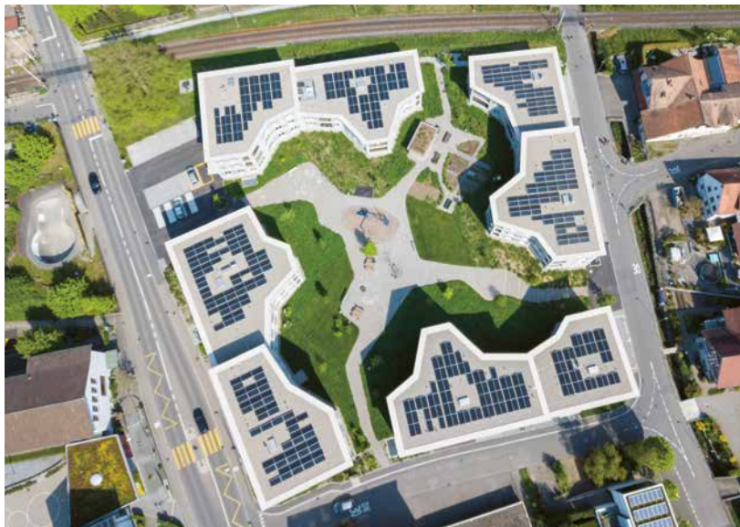
Die Dachlandschaft zeigt es: Die WG Linde hat die Zeichen der Zeit erkannt und leistet ihren Beitrag zur Energiewende. Foto: René Haag
